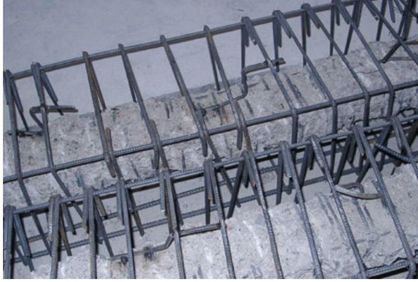
Şekil 3. Yeni donatı kafesi teşkili ve Z demiri uygulama detayı
