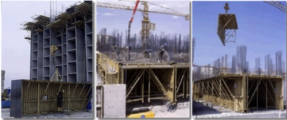
Şekil 1. Tünel kalıp ve yapım tekniği 1
